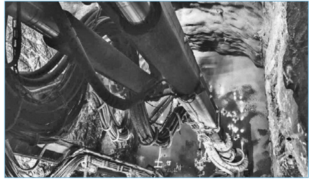
Der Ausbruch des ersten Lagerstollens mit einer Länge von rund 350 m beginnt.
