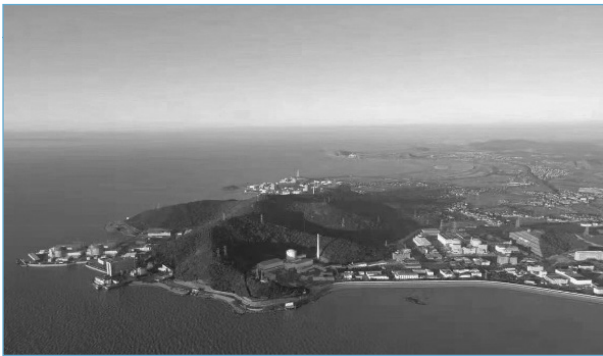
La centrale nucléaire de Qinshan, composée de sept tranches, fournira également de la chaleur à distance.
