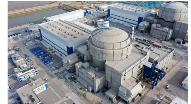
Fuqing 6 produira 10 millions de MWh électriques par an. (Photo: CNNC)
