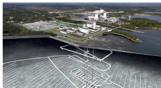
Photomontage du dépôt profond de Forsmark. Le système de tunnels s'étend sur une longueur totale de 60 kilomètres. Le dépôt profond possède une superficie de trois à quatre km 2 sous terre. Il se trouve à une profondeur de 500 mètres. (Photo: SKB)
