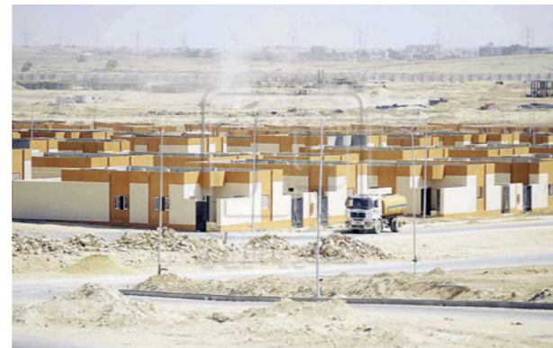
Les bâtiments auxiliaires sont déjà en construction sur le site d'El Dabaa, en Égypte. (Photo: ENRRA)
