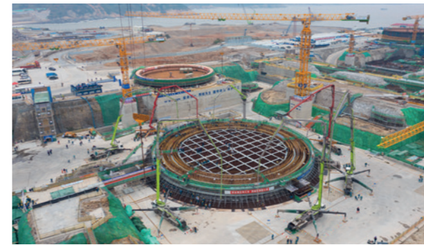
Les travaux de construction de la tranche Sanaocun 2, du type Hualong-One, ont été lancés officiellement. (Photo: CGN)
