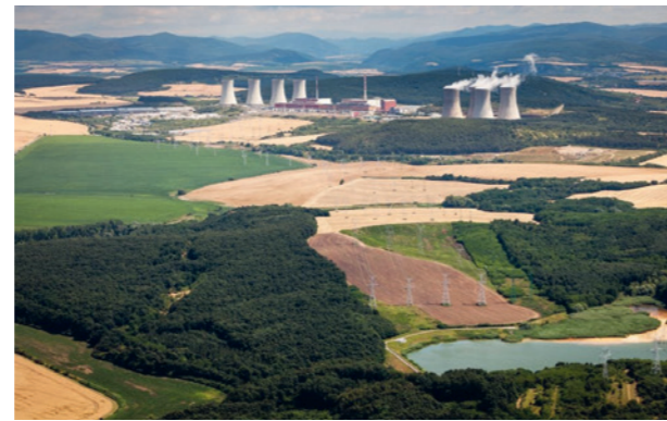
Prise de vue aérienne de la centrale nucléaire slovaque de Mochovce. (Photo: Slovenské elektrárne)
