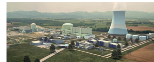
Représentation du site de Krško. La Slovence souhaite sortir du charbon d'ici à 2033. «Nous avons donc lancé rapidement la construction de la tranche 2», a déclaré le ministre des Infrastructures, Jernej Vrtovec. (Photo: GEN Group)
