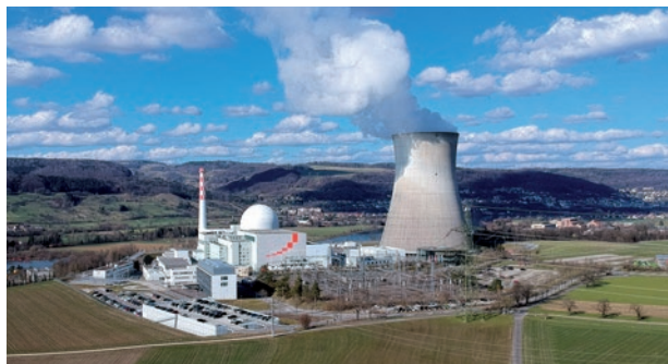
Das Kernkraftwerk Leibstadt aus der Vogelperspektive. (Foto: Max Brugger)
