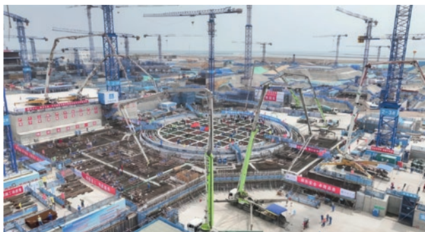
Am Kernkraftwerksstandort Shidaowan stehen mit dem Giessen des ersten sicherheitsrelevanten Betons für Shidaowan-2 nun zwei Hualong-One-Reaktoren in Bau. (Foto: Huaneng)
