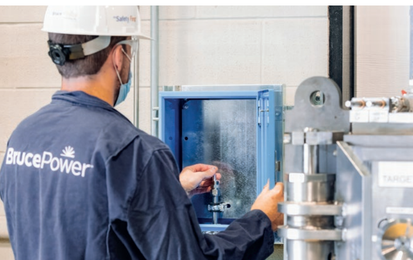
Im Block-7 des kanadischen Kernkraftwerks Bruce wird das Radionuklid Lutetium-177 im Druckschwerwasserreaktor des Typs Candu hergestellt. Ein Mitarbeiter führt im laufenden Betrieb ein Target in das Bruce Power Isotope Production System (IPS) ein, um Ytterbium-176 im Reaktorkern zu Lutetium-177 zu bestrahlen. (Foto: Bruce Power)
