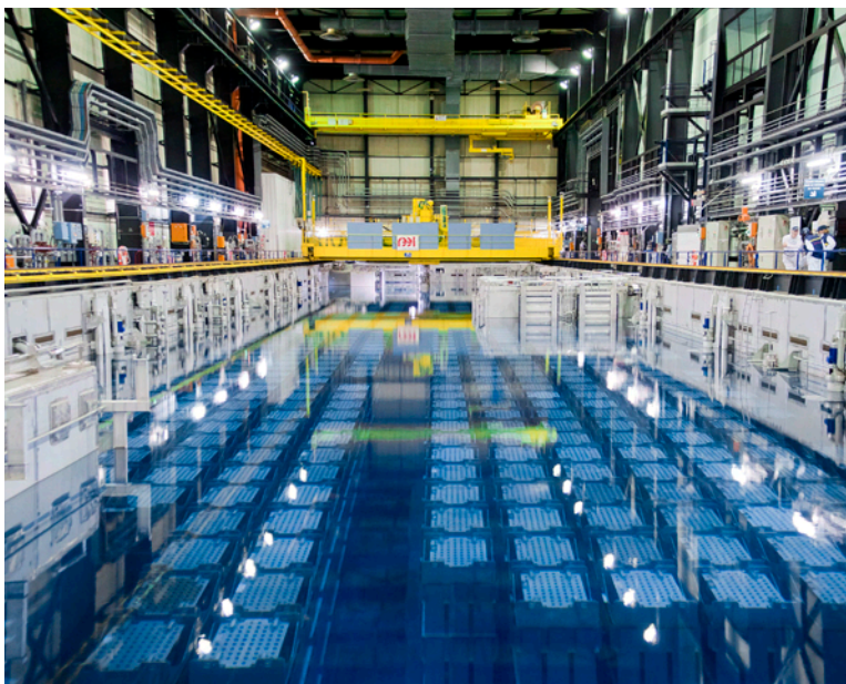
Le retraitement du combustible, la clé d'une économie nucléaire durable. Ici: assemblages combustibles usés avant retraitement dans l'usine de La Hague, en Normandie.
