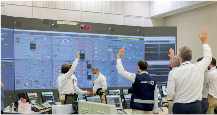
Quatre tranches nucléaires sont prévues sur le site de Barakah, aux Émirats arabes unis. L'une d'entre elles est entrée en service récemment.
