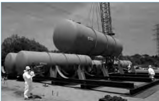
La problématique de la gestion des eaux: installation de réservoirs d'eau sur la centrale nucléaire.
