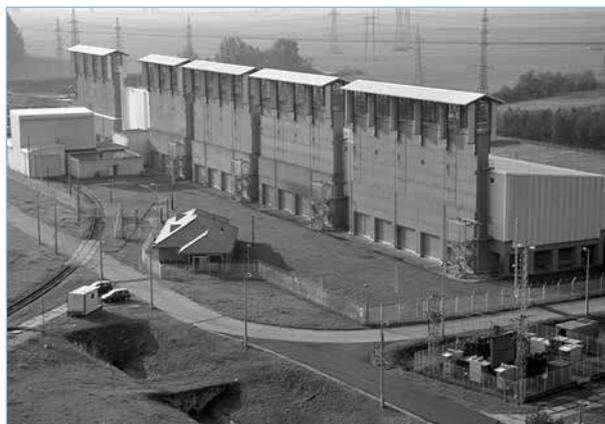
**Dépôt intermédiaire à sec de conception modulaire destiné aux assemblages combustibles irradiés sur le site de Paks.**
