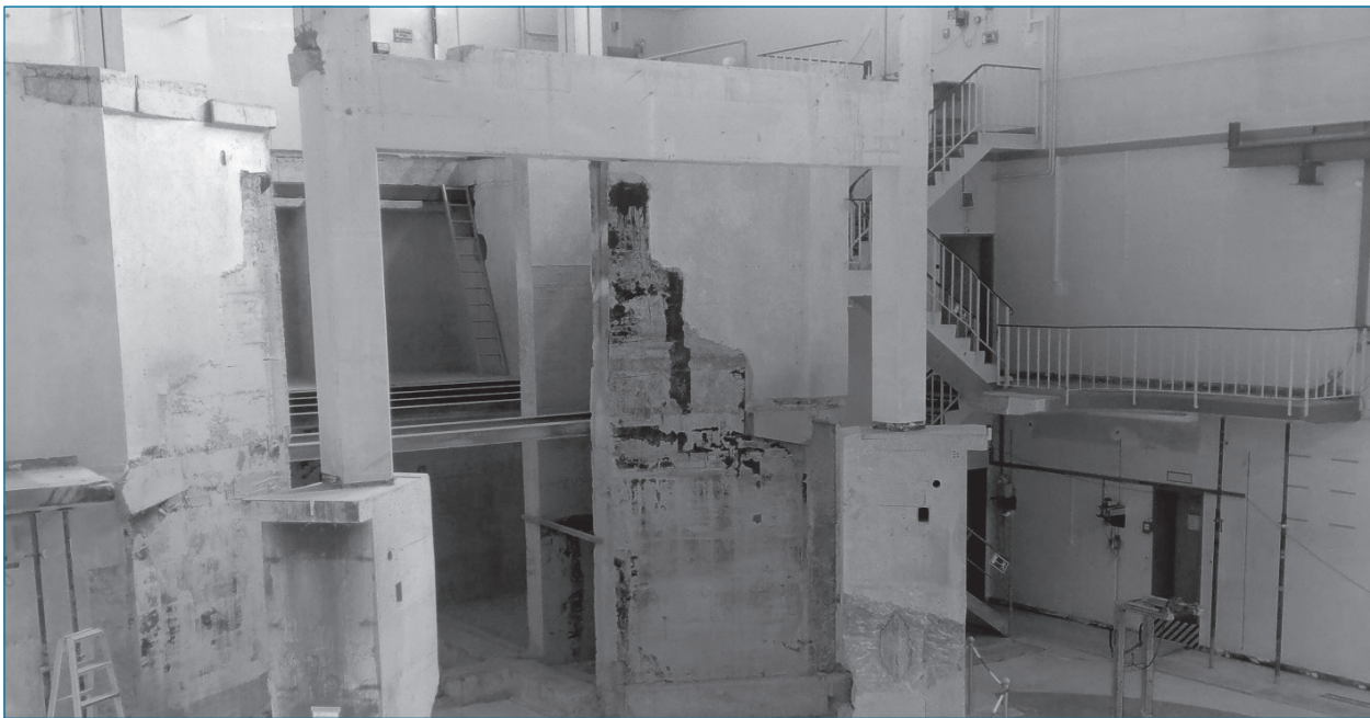
Le bâtiment réacteur de Saphir le 17 avril 2017: vidé de ses installations, il est désormais prêt pour l'élimination des peintures contenant des PCB.
