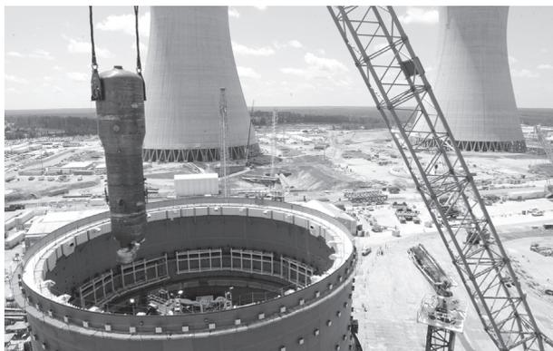
Mitte August 2017 wurde der erste Dampferzeuger ins Reaktorgebäude der AP1000-Einheit Vogtle-3 gesetzt.
