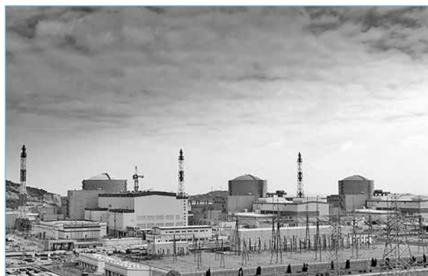
Tianwan 3 a divergé: une troisième tranche du type russe VVER-1000/428 sera ainsi bientôt en service sur le site de Tianwan.
