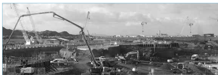
Des mineurs écossais participent aux travaux d'excavation. Environ 4 millions de m 3 de terre ont déjà été retirés. Ce volume permettrait de remplir le stade de Wembley, qui peut accueillir 90'000 spectateurs.
