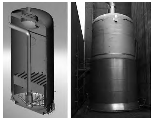
Die neuen Filter haben einen Durchmesser von 3 bis 4 m und sind rund 8 m hoch.
