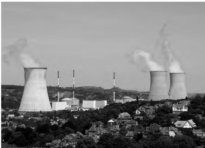
Tihange-1 (PWR, 962 MW), 25 km südwestlich von Lüttich gelegen, soll doch erst 2025 statt 2015 vom Netz genommen werden, da die belgische Regierung andernfalls Engpässe in der Stromversorgung befürchtet.
