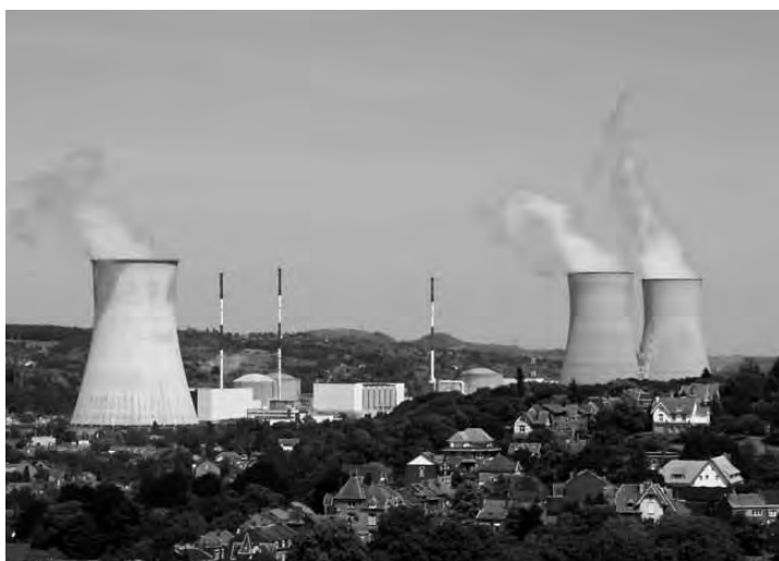
La tranche Tihange 1 (PWR, 962 MW), située à 25 km au sud-ouest de Lüttich, sera déconnectée du réseau non pas en 2015 mais en 2025, le gouvernement belge redoutant des difficultés d'approvisionnement.
