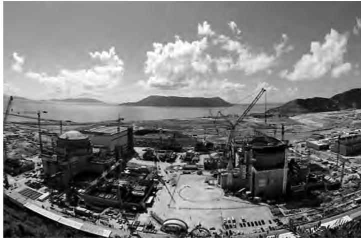
Die Reaktorkuppel von Taishan-2 (rechts im Bild) ist aufgesetzt. Links im Bild sind die Baufortschritte bei Taishan-1 sichtbar.
