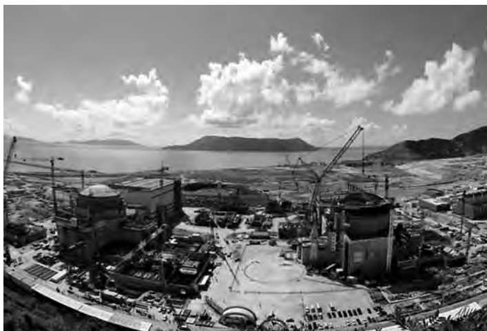
Pose du dôme du réacteur Taishan 2 (à droite). L'avancée des travaux de Taishan 1 est visible sur la gauche de la photo.
