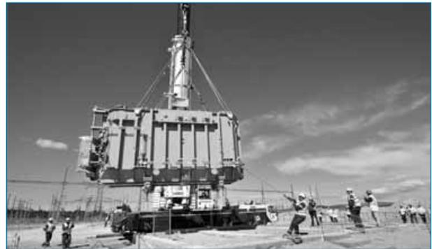
Une grue performante et du personnel qualifié ont permis de positionner avec précision le transformateur de 87 tonnes sur le support qui recouvre la cuve de réception remplie de gravier.
