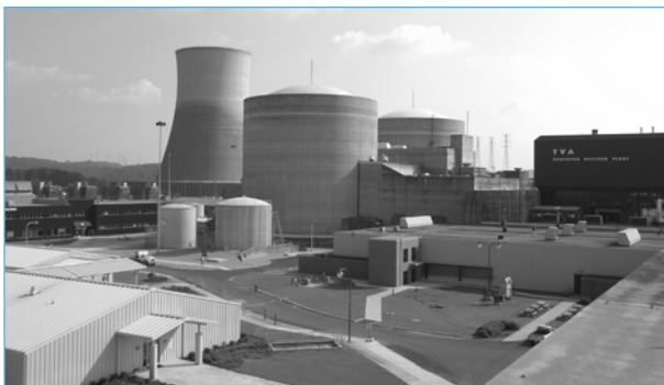
La centrale nucléaire de Sequoyah, dans l'Etat du Tennessee, pourra fonctionner 60 ans.
