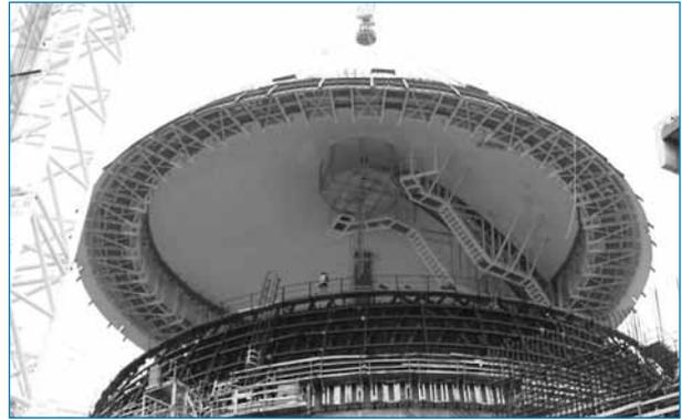
Le dôme du bâtiment réacteur de la tranche nucléaire Novovoronej-II 2 est positionné au millimètre près.
