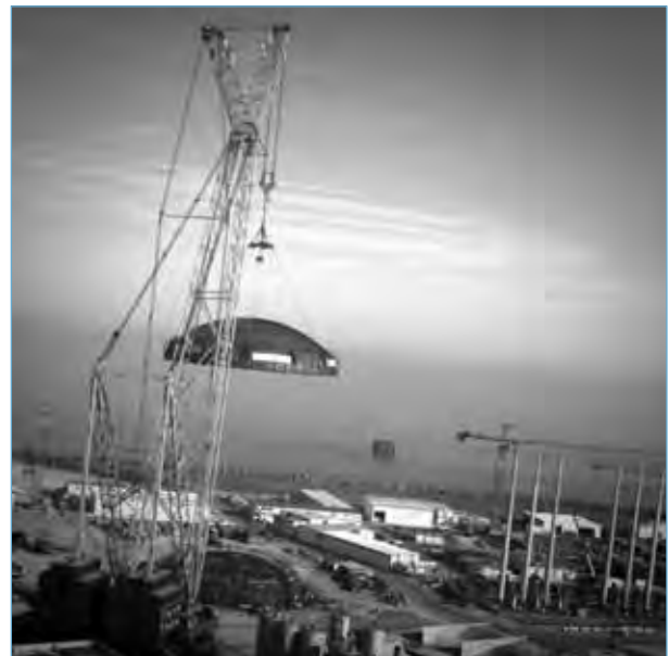
Die 260 t schwere Reaktorgebäude-Kuppel des EPR Flamanville-3 wurde erfolgreich gesetzt.
