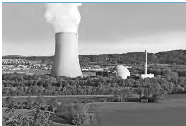
Die elektrische Bruttoleistung des Kernkraftwerks Gösgen beträgt neu 1060 MW und die elektrische Nettoleistung neu 1010 MW.
