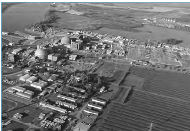
Der Standort Atucha befindet sich 115 km von Buenos Aires entfernt. Die Druckschwerwassereinheit Atucha-2 (692 MW) ist seit dem 27. Juni 2014 am Netz. Dort ist Atucha-1 (335 MW) – vom selben Typ – seit 1974 in Betrieb.
