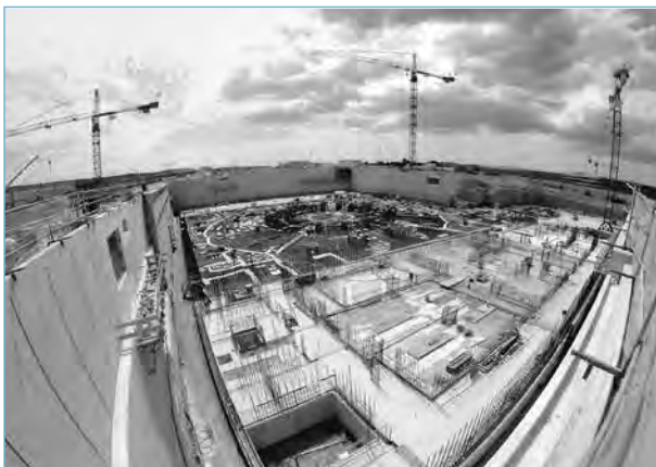
La troisième et dernière section des fondations du bâtiment Tritium, dans la partie sud de la fosse, a été réalisée le 26 juin 2014.
