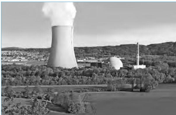
La puissance électrique brute de la centrale nucléaire de Gösgen est désormais de 1060 MW et sa puissance électrique nette de 1010 MW.
