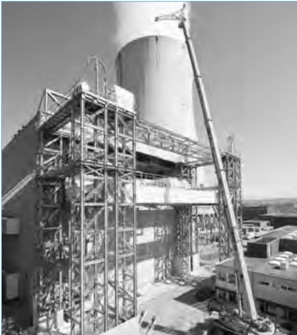
Montage de la nouvelle grue de la salle des machines en septembre 2012.
