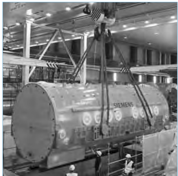
Pose du nouveau stator.
