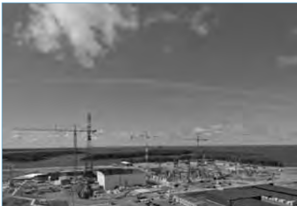
Olkiluoto 3: état d'avancement des travaux le 18 juillet 2006... Photo: TVO
