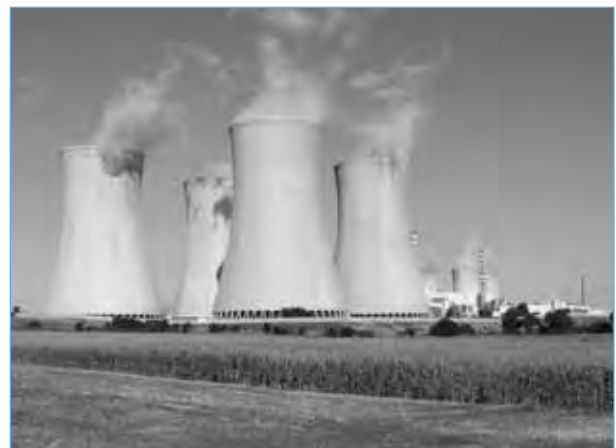
La centrale nucléaire de Dukovany comprend quatre réacteurs du type VVER-440/V213 qui ont été mis en service de 1985 à 1987 et rééquipés depuis lors.
