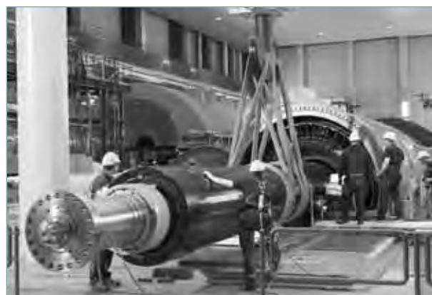
Mise en place du nouveau rotor.
