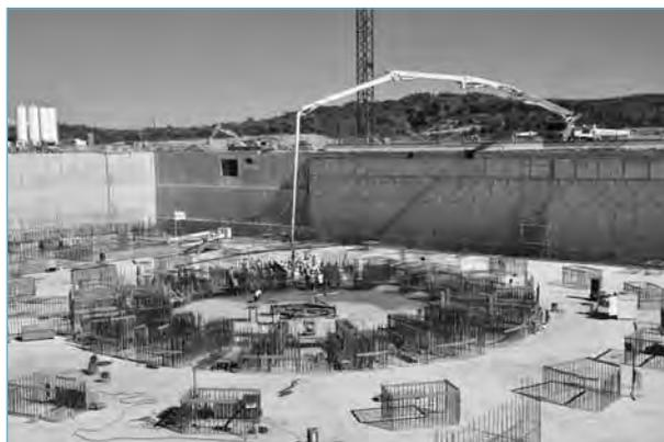
**Le coulage du béton dans la partie centrale des fondations marque l'achèvement du radier du complexe Tokamak d'Iter.**
