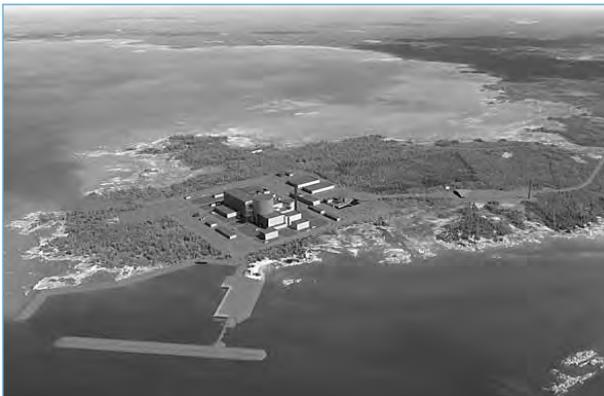
Photomontage de Hanhikivi 1, réacteur à eau sous pression de 1200 MW du type russe avancé AES-2006 qu'il est prévu de construire sur le site de Pyhäjoki. Ce projet a été approuvé par le gouvernement finlandais.
