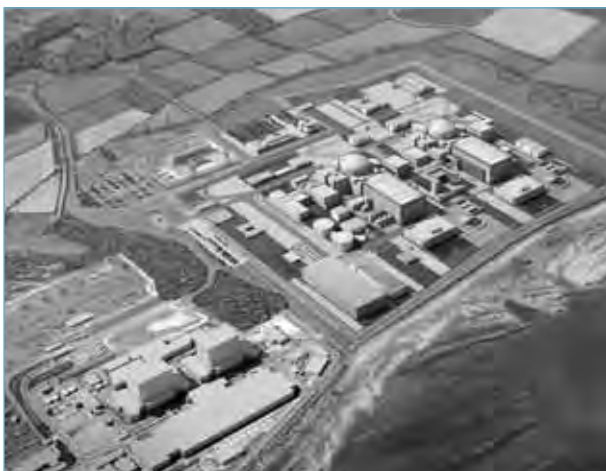
L'accord conclu entre le gouvernement britannique et le groupe français EDF ouvre la voie à la construction de la première centrale nucléaire de Grande-Bretagne depuis 1995 (photomontage de Hinkley Point C).
