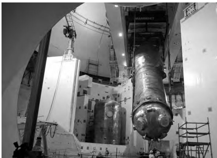
Début décembre 2010, le troisième générateur de vapeur a été installé dans le bâtiment réacteur d'Olkiluoto 3.
