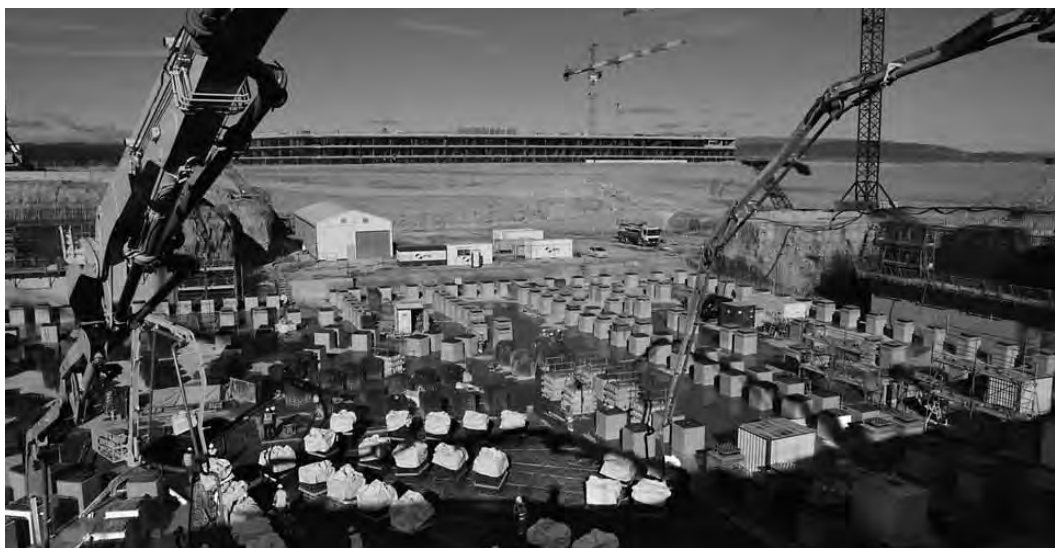
Les fondations du bâtiment du tokamak ont été achevées en décembre 2011.
