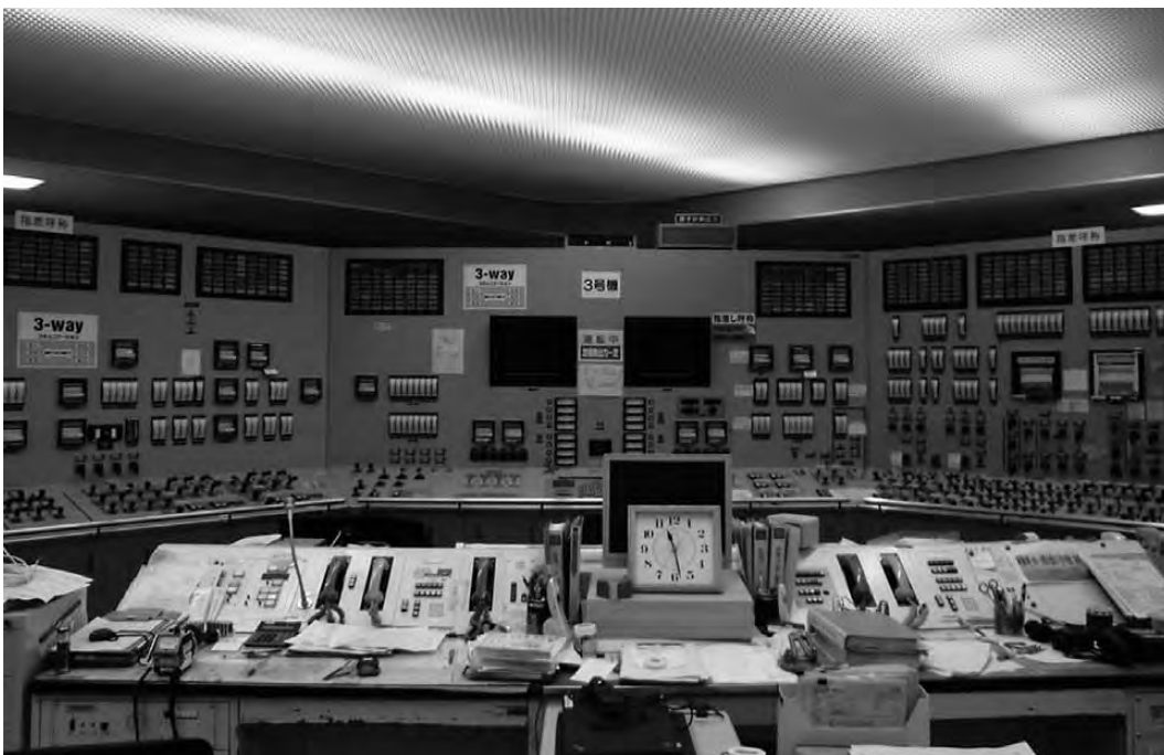
La salle de contrôle presque intacte de la tranche 3, photographiée le 22 mars 2011.
