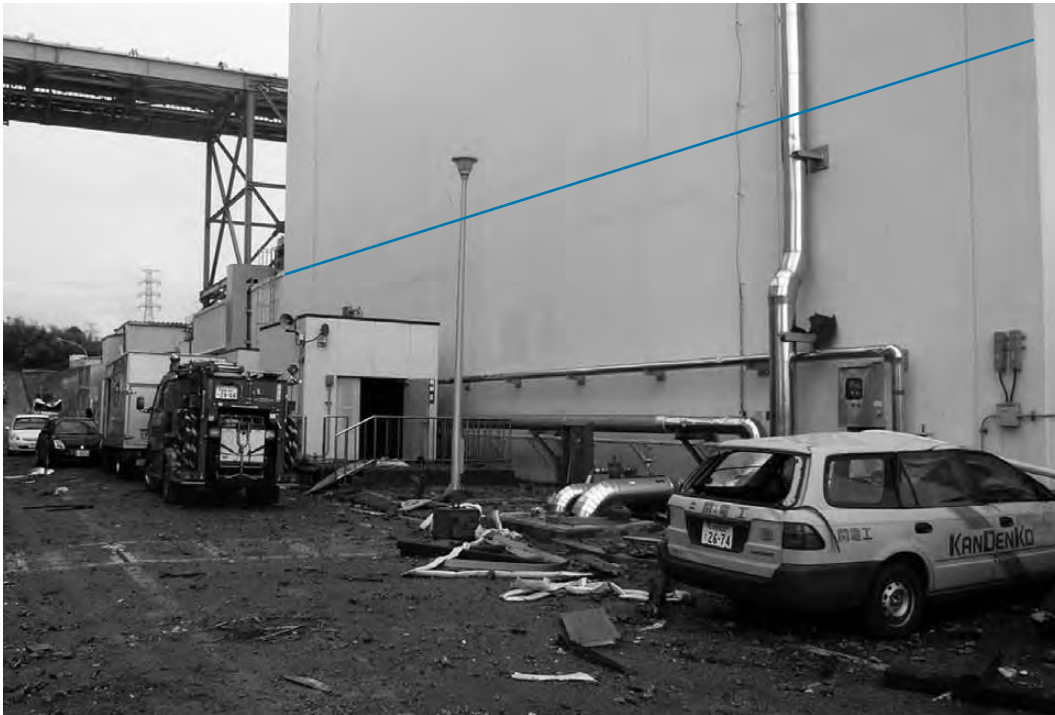
Bâtiment réacteur de la tranche 3: la ligne bleue indique le niveau de la crue.
