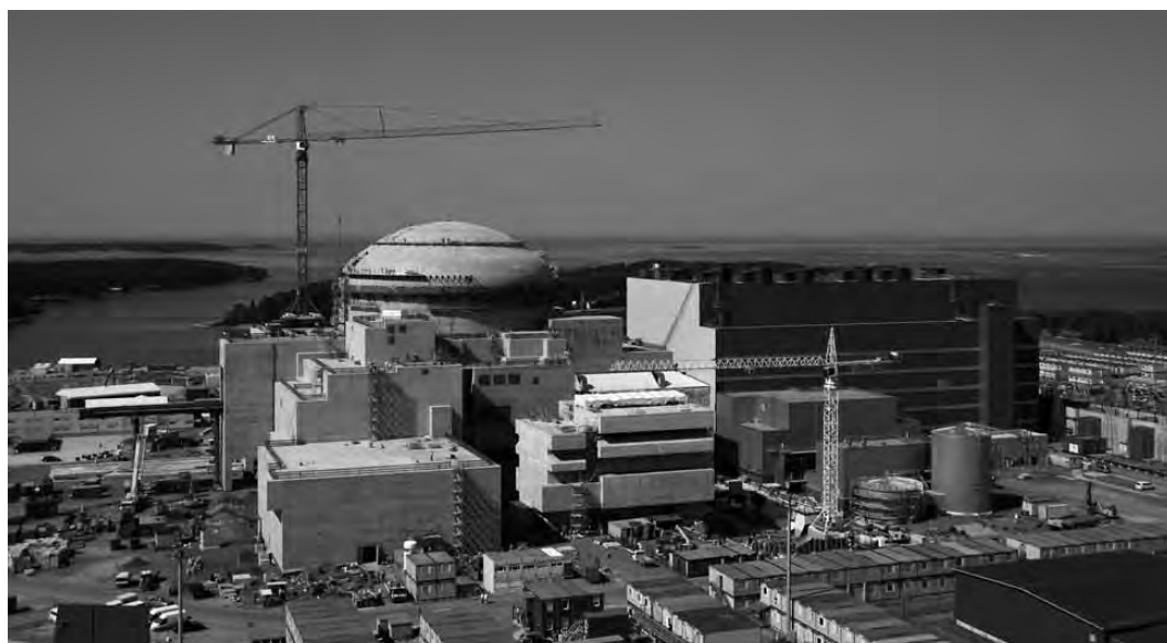
So präsentiert sich das fertig betonierte Reaktorgebäude der Kernkraftwerkseinheit Olkiluoto-3 am 10. Juni 2011.
