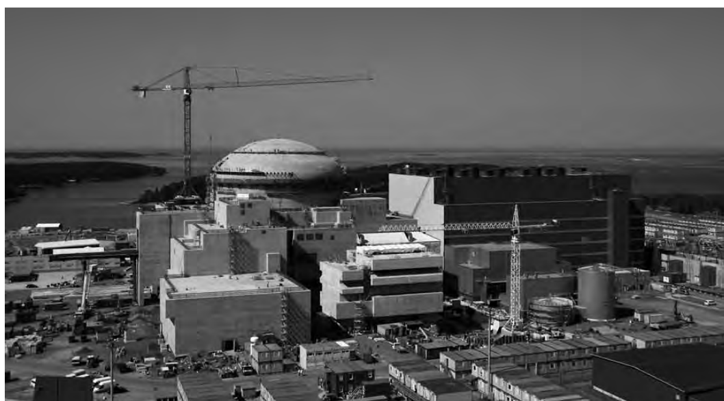
C'est ainsi que se présentait le 10 juin 2011 le bâtiment réacteur entièrement bétonné de la tranche nucléaire d'Olkiluoto 3.
