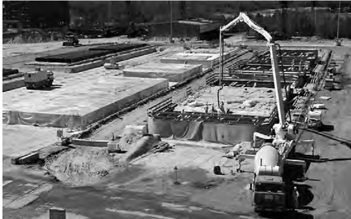
Vorbereitungsarbeiten für den Bau der neuen Sicherheitshülle um den zerstörten Kernkraftwerksblock von Tschernobyl sind im Gang.
