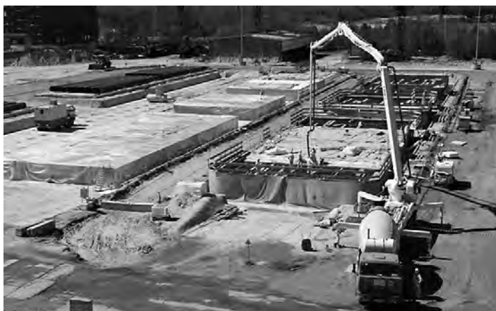
Travaux préparatoires en vue de la construction du nouveau sarcophage de Tchernobyl.
