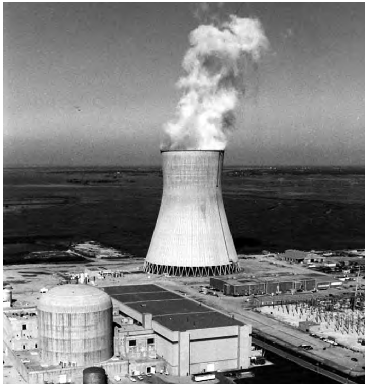
La centrale nucléaire de Hope Creek 1, dans l'Etat du New Jersey, pourra être exploitée pendant 20 années supplémentaires.
