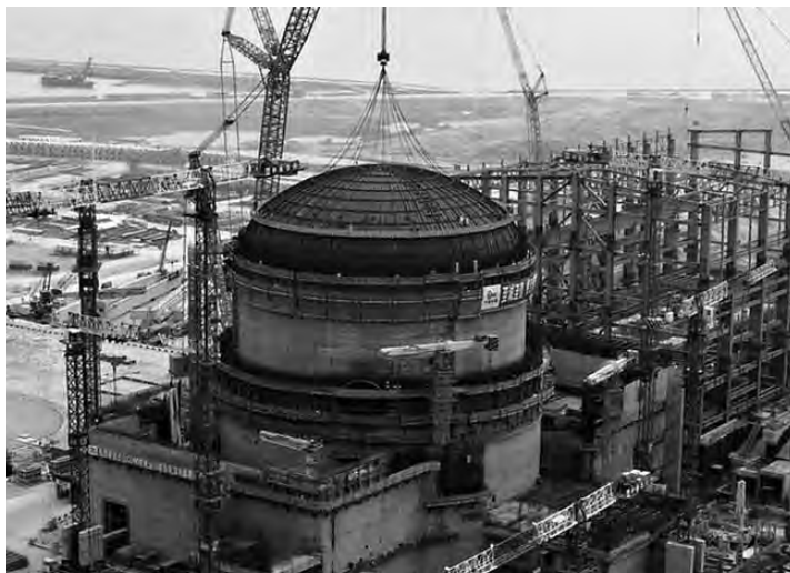
Die Kuppel des ersten EPR in China, Taishan-1, ist gesetzt.
