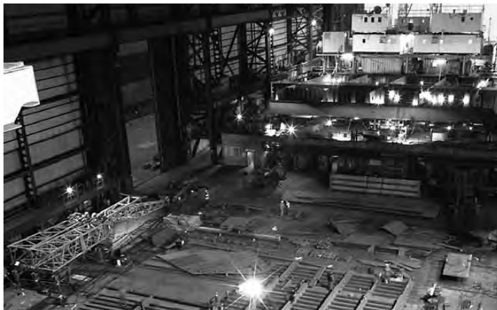
Le chantier naval de Birkenhead est capable de fabriquer des modules pesant jusqu'à 5000 tonnes (vue de la halle de montage).
