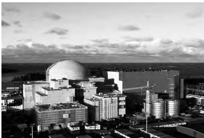
La tranche Olkiluoto 3, le premier EPR du monde, est achevée à 80% (photo du 13 octobre 2011).
