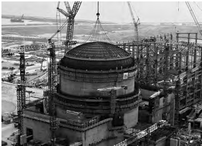
Pose du dôme de Taishan 1, premier EPR de Chine.
