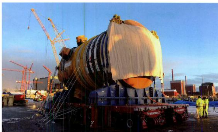
Figure 2 La 3 e génération en construction: livraison de la cuve de confinement du réacteur pour le réacteur européen à eau pressurisée (EPR) à Olkiluoto en Finlande. En Asie, plusieurs réacteurs de la 3 e génération sont déjà en exploitation.
