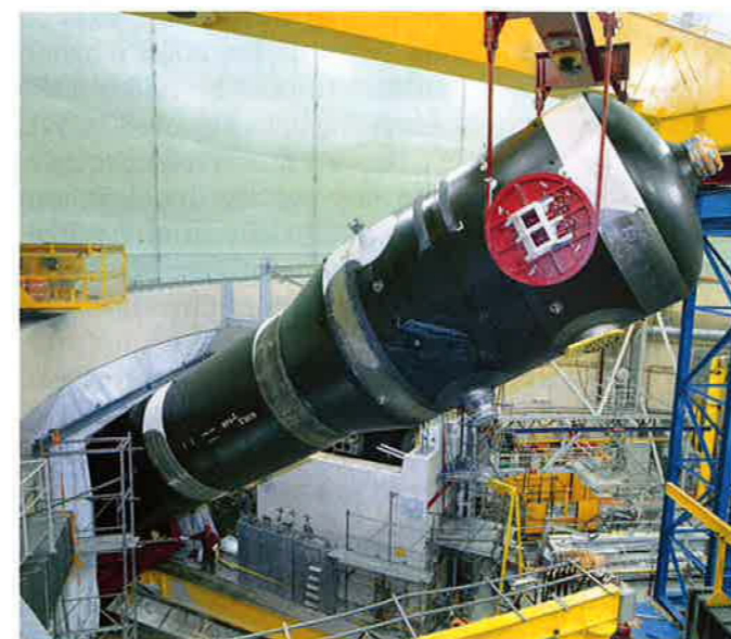
1999: neuer Dampferzeuger im Kernkraftwerk Beznau
