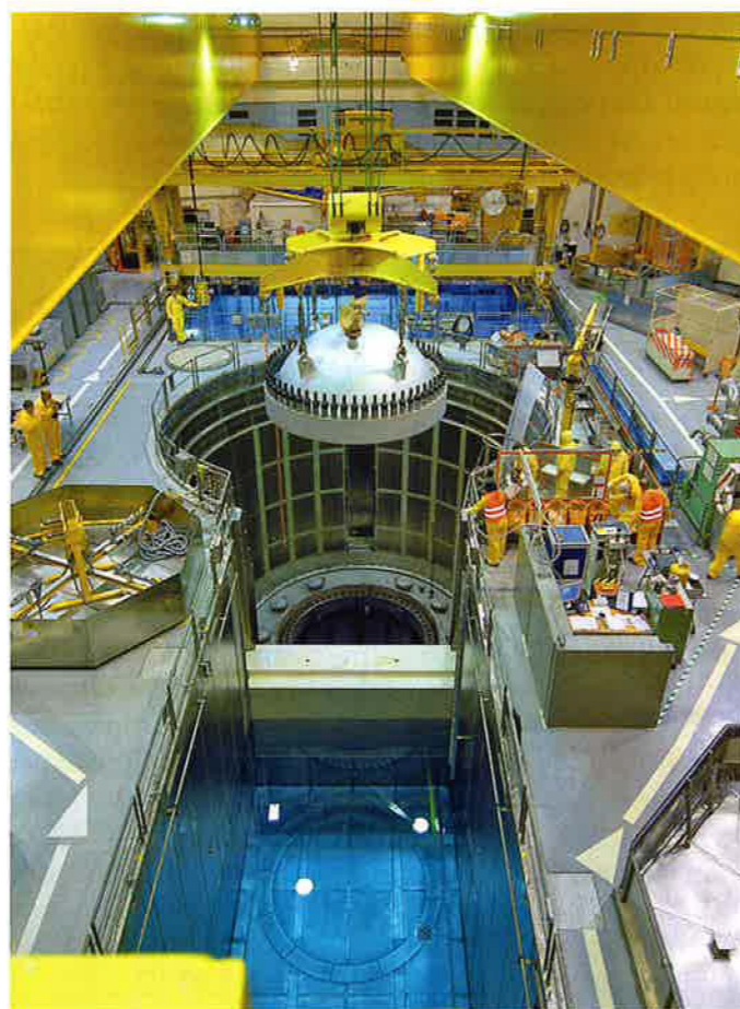
Sorgfältige Wartung zahlt sich aus: Revisionsarbeiten im Kernkraftwerk Mühleberg
