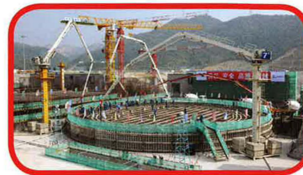
Ausbau der Kernenergie in China: Am 23. Dezember 2013 wurde der erste Beton für Yangjiang-6 gegossen.
