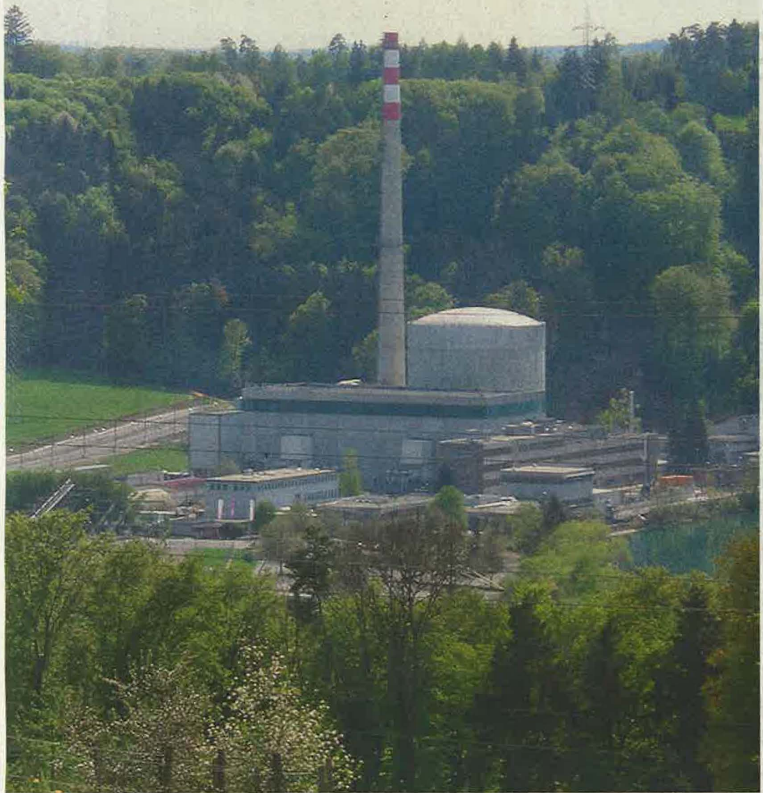
Muss ab 2019 mit Strom aus ausländischen Kernanlagen und fossilen Anlagen ersetzt werden: Das Kernkraftwerk Mühleberg versorgt 400 000 Menschen mit Strom.
